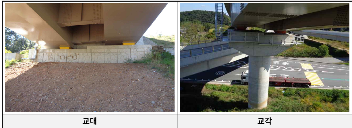
[교대 및 교각 전경]
